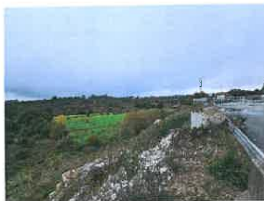
Fig. 42 – Vista geral do prédio de onde será destacada a parcela, e desnível para a rua a norte da parcela e prédio da Adega
