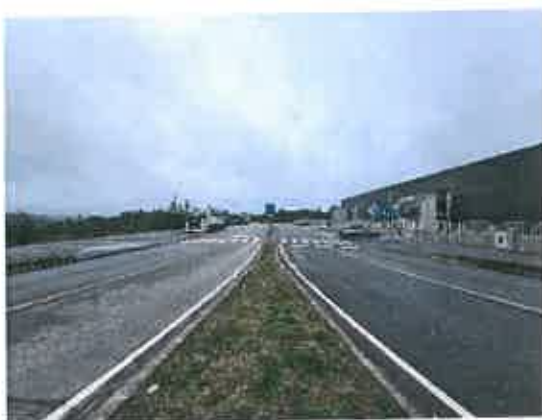
Fig. 41 – Arruamento a norte do prédio da Adega Cooperativa e junto parcela. Acesso ao prédio da Adega e superfície comercial
